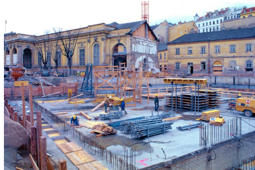
Baustelle mumok © Margherita Spiluttini
