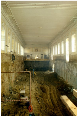
Baustelle Halle E&G © Margherita Spiluttini
